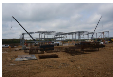
建設中の英国 生産拠点 (Newton Aycliffe)
