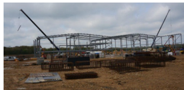
建設中の英国生産拠点 (Newton Aycliffe)
